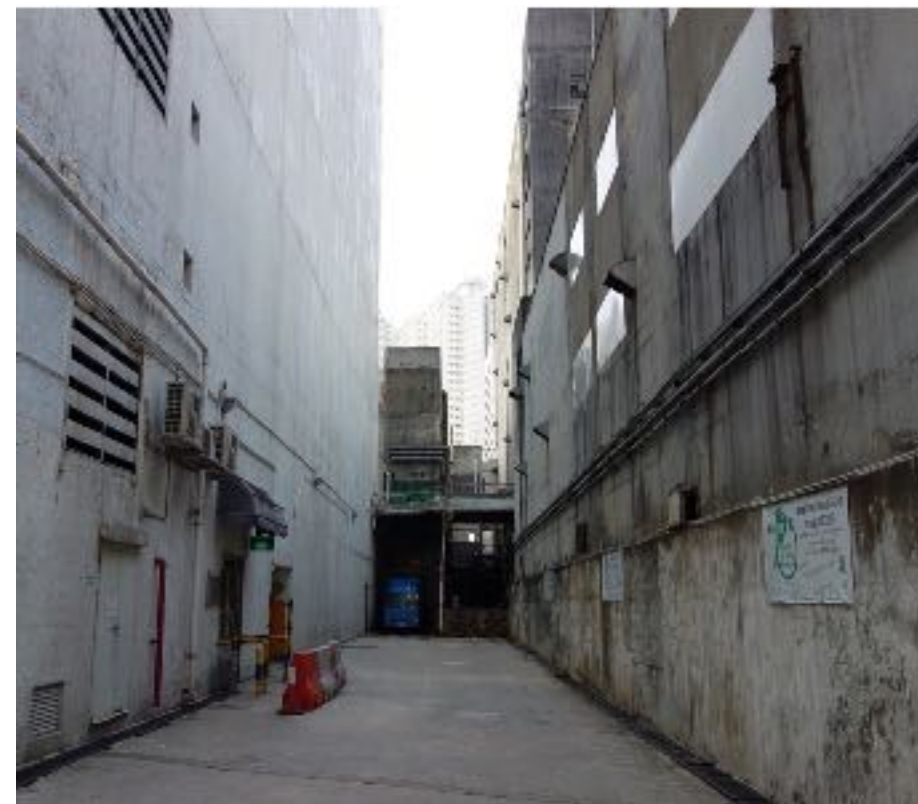
Original status of Pak Tin Par Lane 白田壩里原貌
