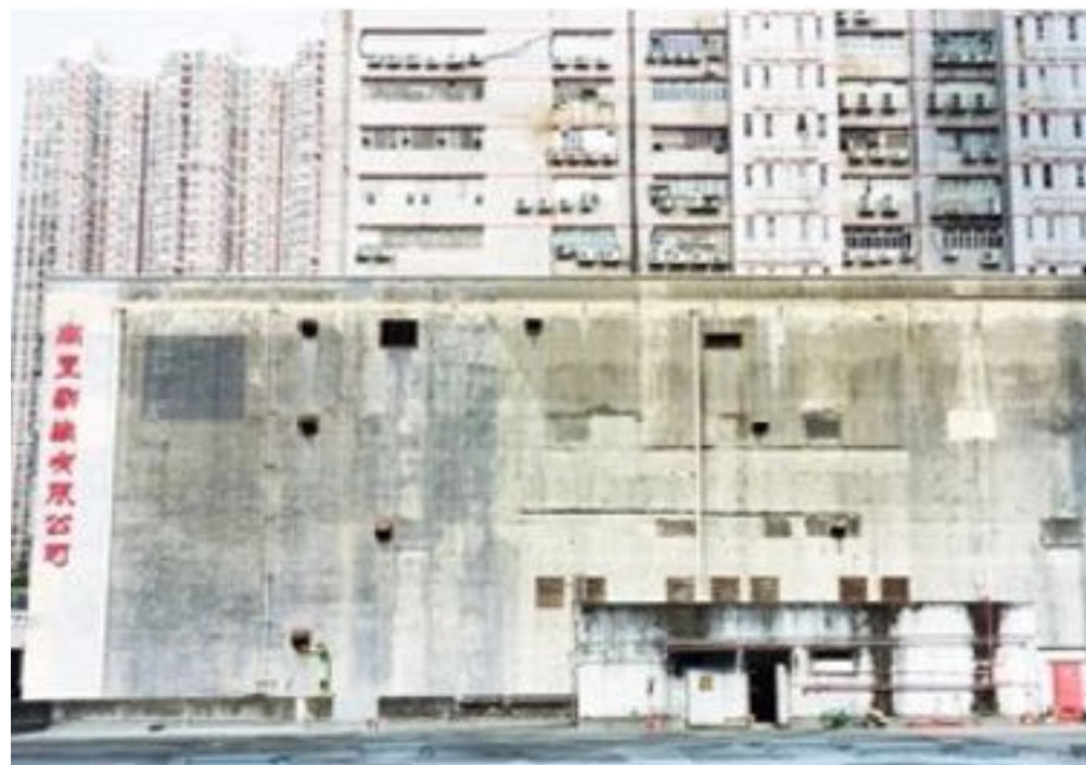
The Park before reconstruction 未活化前的紗廠公園
